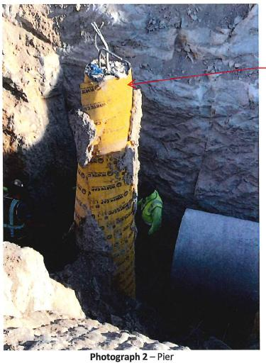
**REMOVE SONOTUBE BEFORE BACKFILLING** THE SOIL
